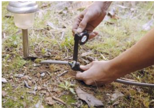
Reparation Elektriske forbindelser
